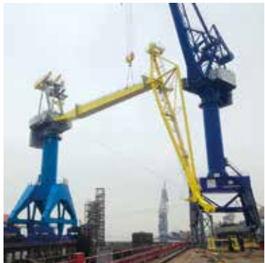
Монтаж портального монтажного крана на территории АО «Адмиралтейские верфи»
