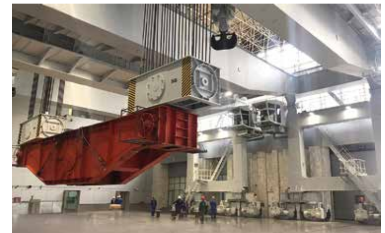
Модернизация полукрановых кранов г/п 500/100-10 т машинного зала, Филиал ПАО «РусГидро» - Саяно-Шушенская ГЭС имени П.С.Непорожнего
