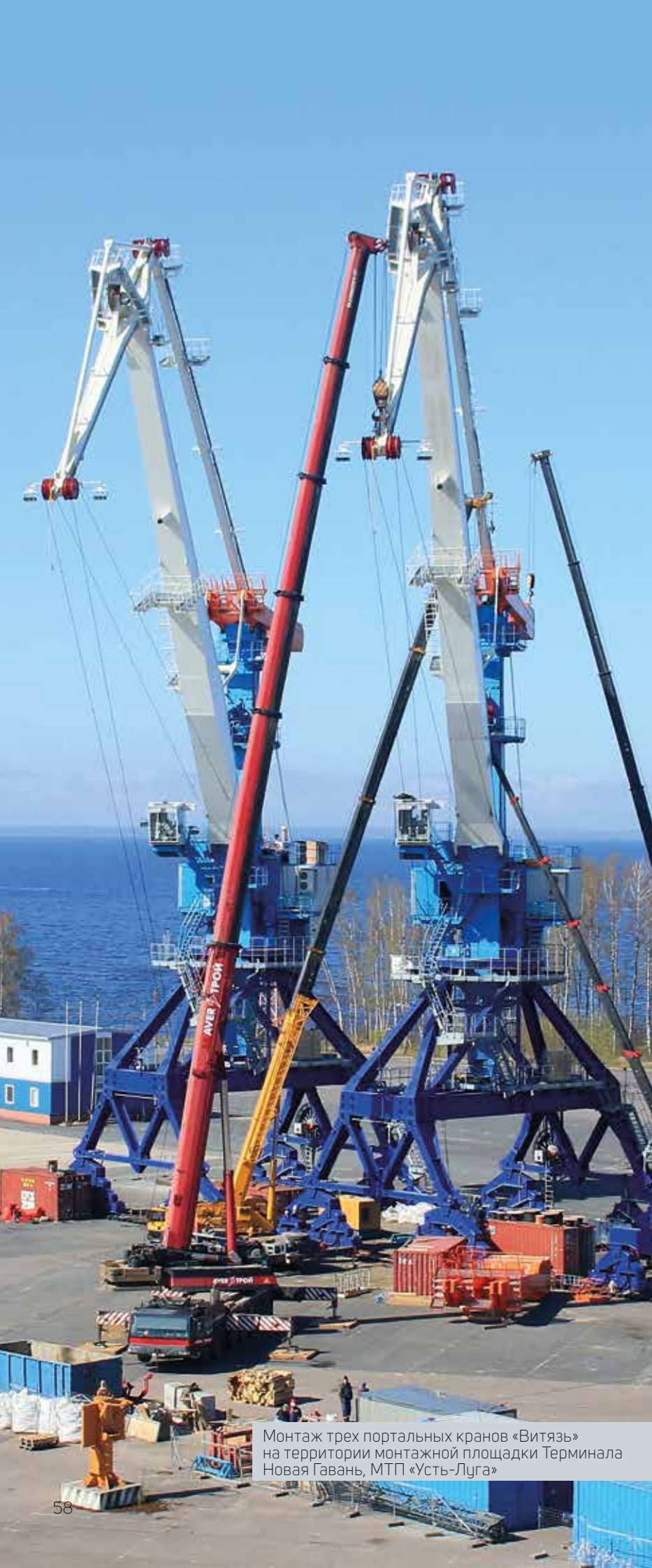
Монтаж портального монтажного крана на территории АО «Адмиралтейские верфи»
